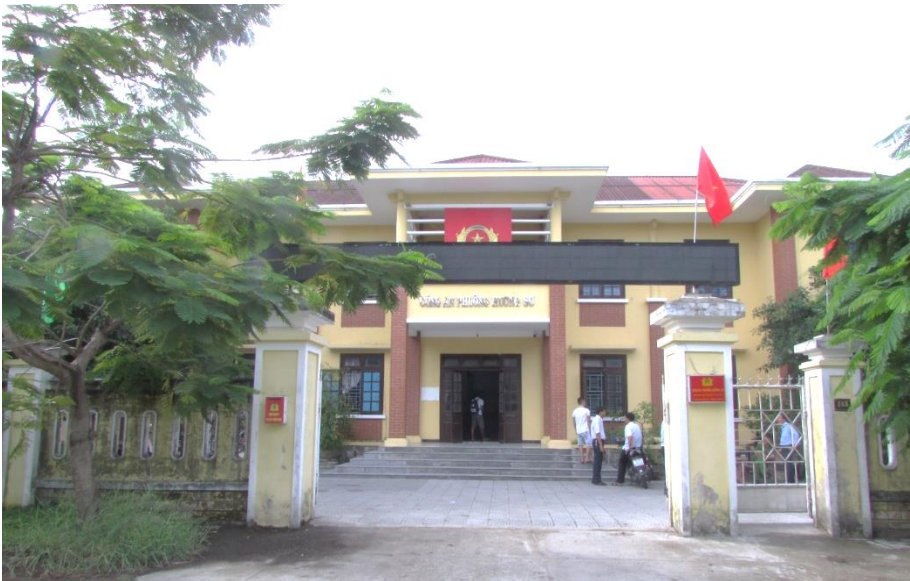
Trụ sở Công an phường Hương Sơ
